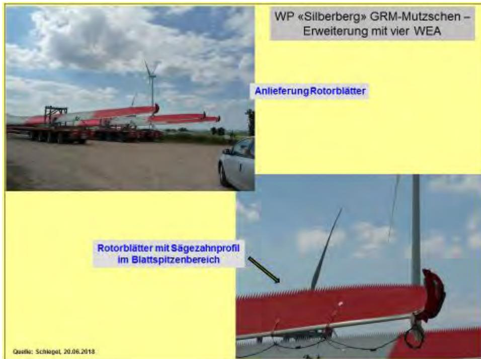
Abb. 46: Anlieferung Rotorblätter E92-2.35MW/NH75m
