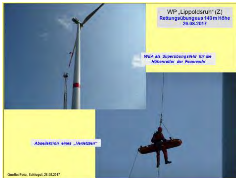
Abb. 35: Höhenrettungsaktion von einer WEA-3MW-Klasse
