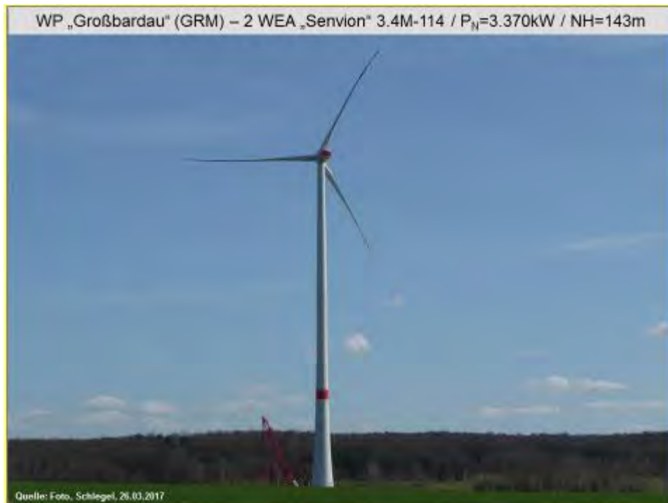
Abb. 32: WEA-Errichtung WP „Großbardau“ (GRM)
