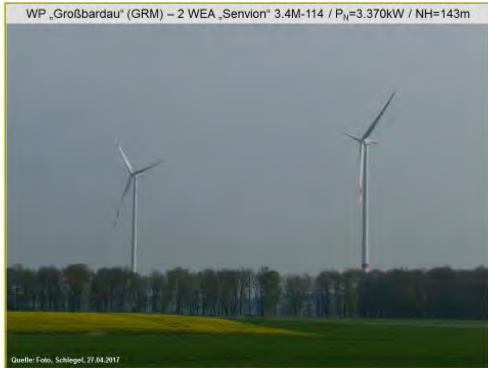
Abb. 35: WEA-Errichtung WP „Großbardau“ (GRM)
