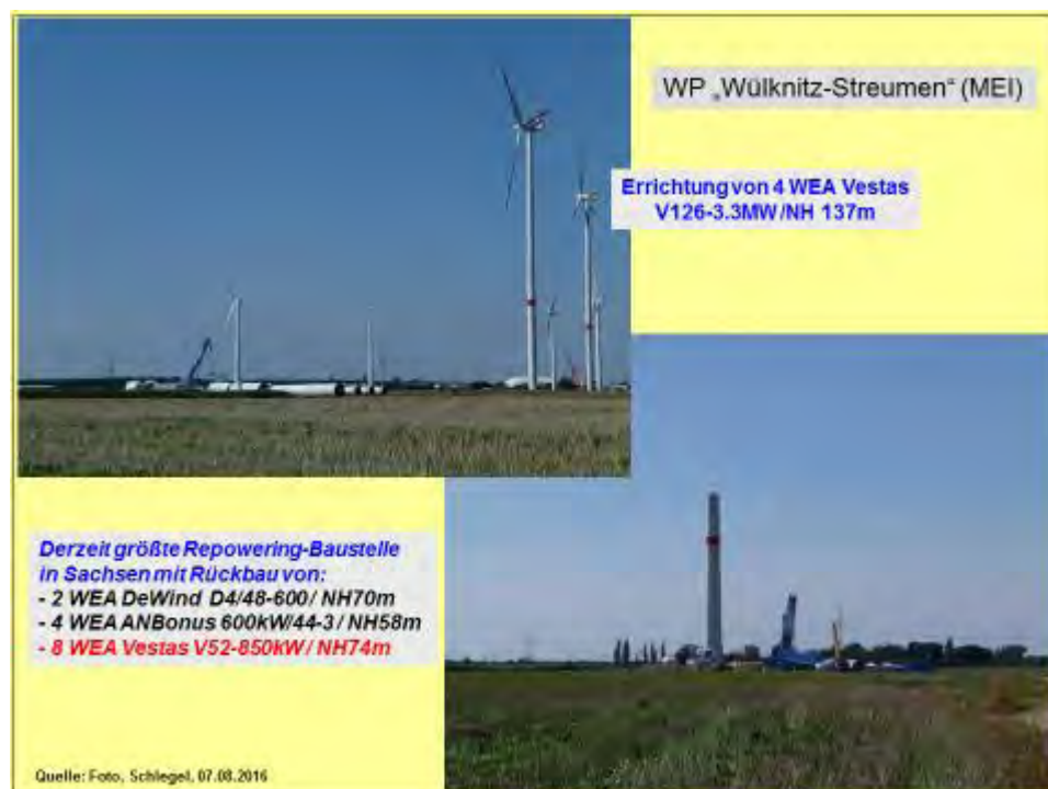
Abb. 28: WEA-Neubau und -Rückbau im WP „Wülknitz-Streumen“
