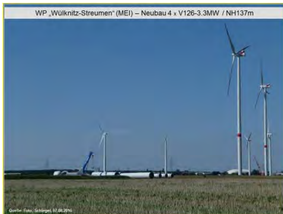
Abb. 29: Errichtung von Vestas V126-3.3MW im WP „Wülknitz-Streumen“ (MEI)
