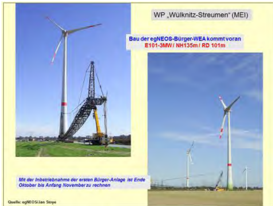
Abb. 30: Bürgerwindenergieanlage E101-3MW im WP „Wülknitz-Streumen“ (MEI)
